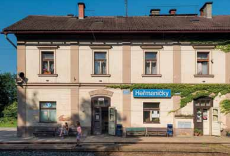
Nádražní budova v Heřmaničkách
